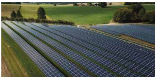
Campo fotovoltaico con strutture fisse
